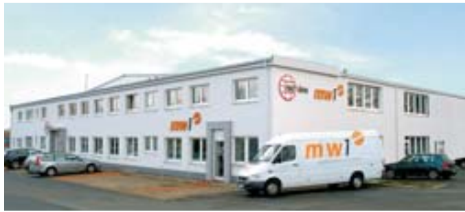
Die neue Fassade am Meierweg 1
